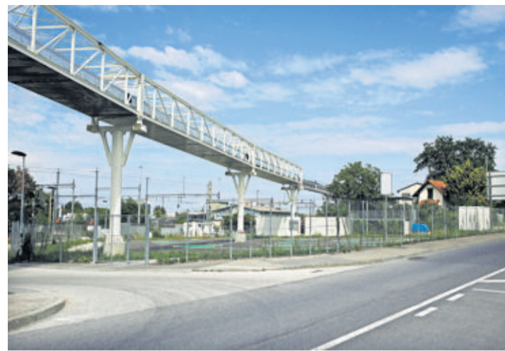
D'En Chardon à la gravière d'Epeisses, la bande convoyeuse, vue ici de la route du Nant-d'Avril, parcourt 1,6 km. STEVE IJUNCKER-GOMEZ
